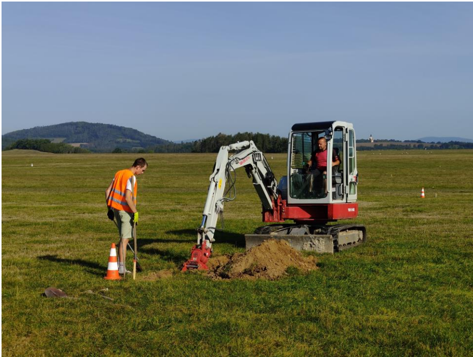
První metry výkopu pro kabely světelného zabezpečovacího zařízení (SSZ) „Přistání“ technologického kontejneru s ovládáním SSZ a záložním zdrojem elektřiny
