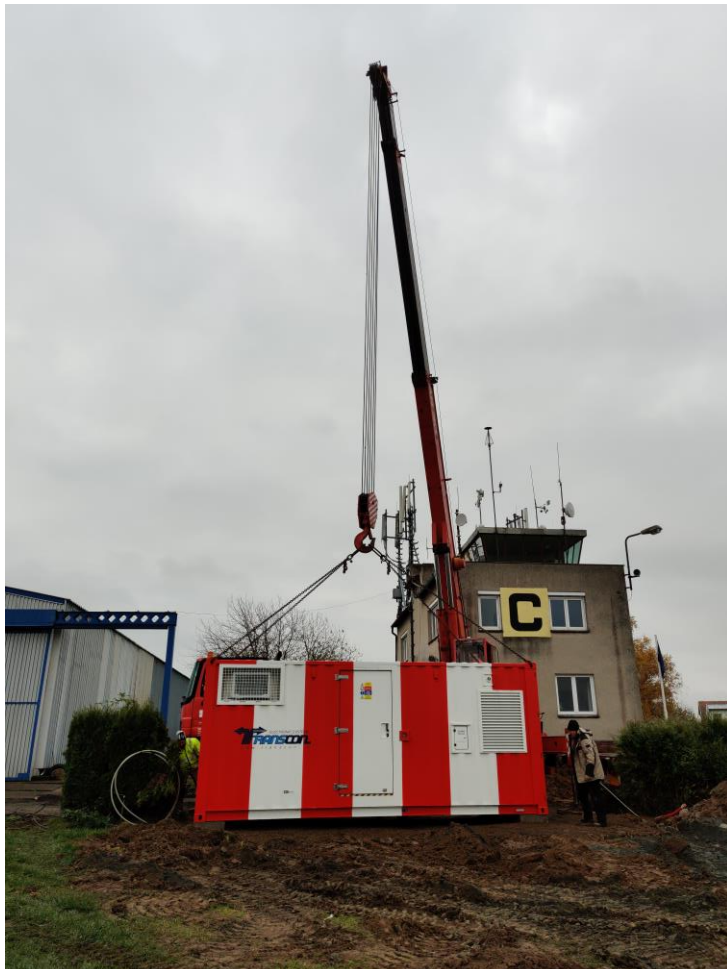
První metry výkopu pro kabely světelného zabezpečovacího zařízení (SSZ) „Přistání“ technologického kontejneru s ovládáním SSZ a záložním zdrojem elektřiny
