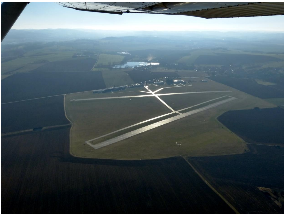
Pohled na letiště pár dnů po položení posledních plastových dlaždic
